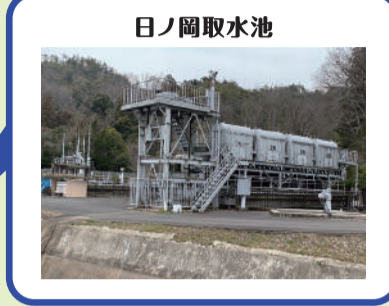
日ノ岡取水池
